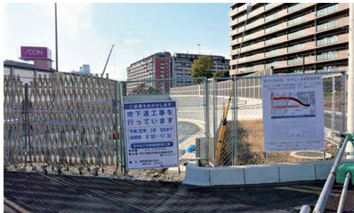
建設作業が行われている地下道(2017年3月、OIC側から撮影)
