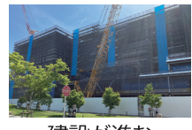
建設が進む OIC新棟
